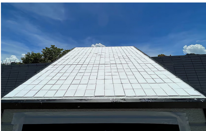
Slika 1 – Prototip ultra bijele keramike na krovu
