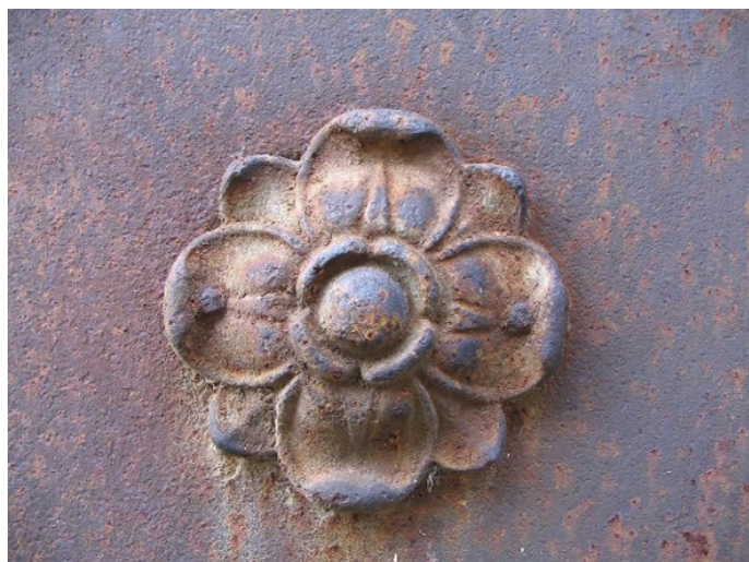
Slika 1 – Prikaz korozije metala 1
