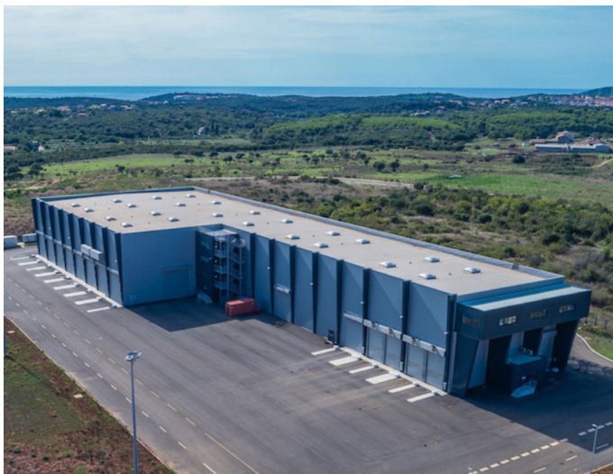
Slika 3 – Hala za Mehaničko-biološku obradu
