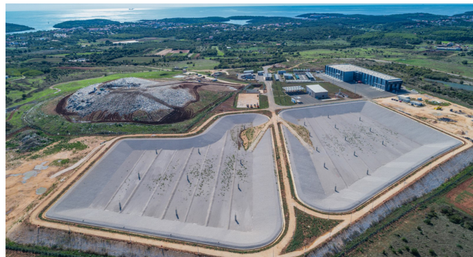
Slika 5 – Odlagališne plohe izvedene kao bioreaktori
