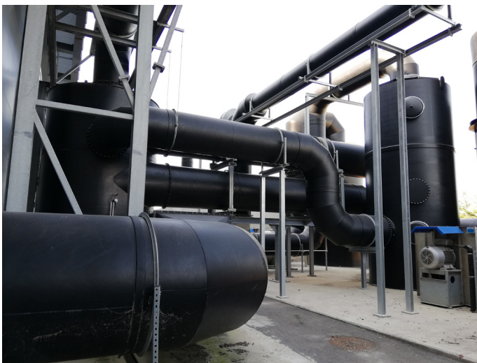
Slika 7 – Nakon što je prošao kroz tri različita pročišćivača, zrak iz postrojenja izlazi čist
