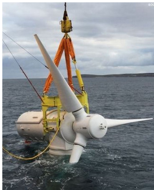
Slika 1 – Postavljanje plimne turbine
