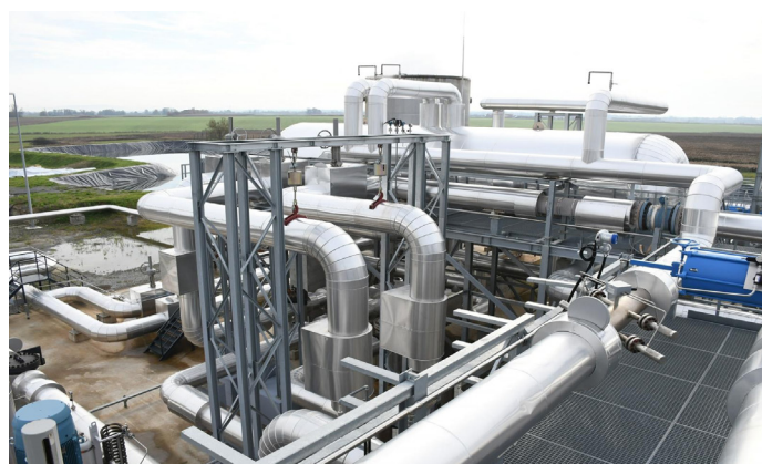
Slika 1. i 2. – Geotermalna elektrana Velika 1
