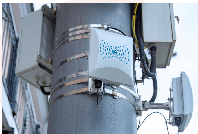
Slika 3 – 5G antena postavljena na baznu stanicu
