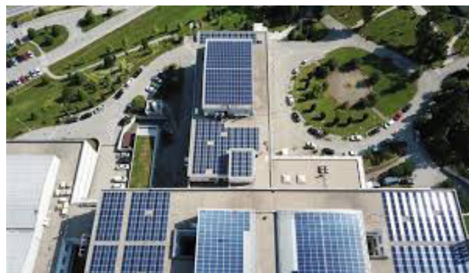
Slika 1 – Krov Opće bolnice Zabok
