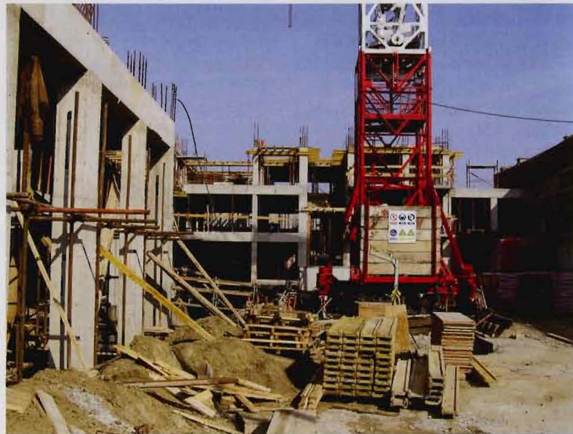
Pogled na gradilište dvorišnog dijela građevine
