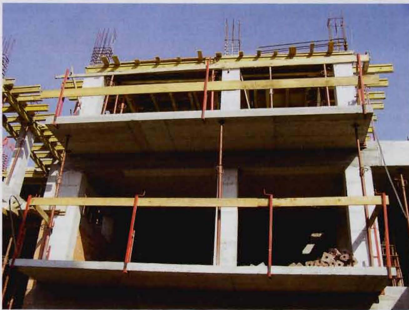
Detalj pročelja lamele 1 u gradnji
