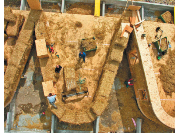
■ Mogući izgled apartmana u izgradnji
