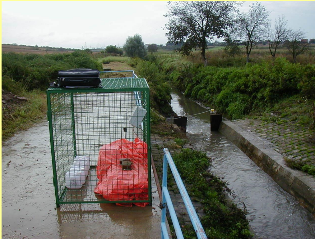
Lokacija uzorkovanja na glavnom kolektoru otpadnih voda grada Đakova
