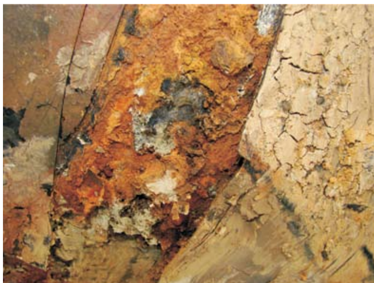
Jamičasto korozivsko oštećenje ugljičnog čelika izazvano djelovanjem sulfat-reducirajućih bakterija. Pitting corrosion damage of carbon steel developed under the influence of sulfate reducing bacteria.
