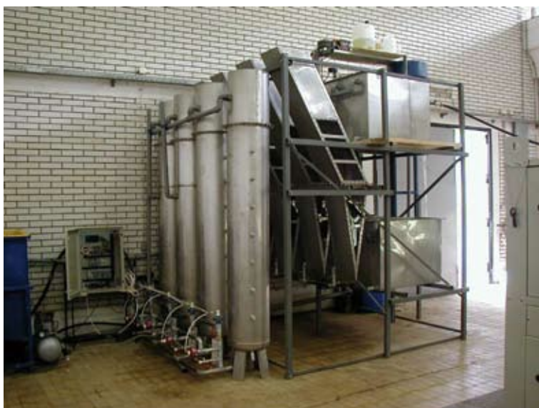
Pročiščavanje površinskih voda – pokusno postrojenje. Surface water treatment – pilot plant.
