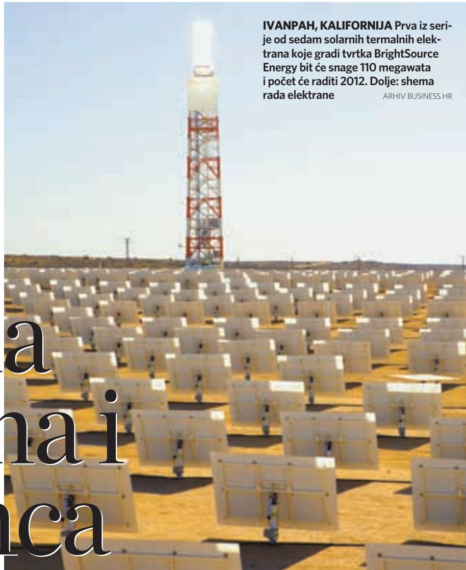
**IVANPAH, KALIFORNIJA** Prva iz serije od sedam solarnih termalnih elektrana koje gradi tvrtka BrightSource Energy bit će snage 110 megawata i počet će raditi 2012. Dolje: shema rada elektrane
